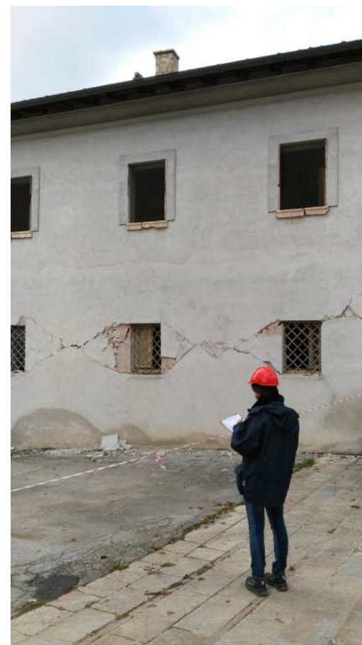
Sisma Centro Italia 2016 Rilievo AeDES – lesioni di taglio
