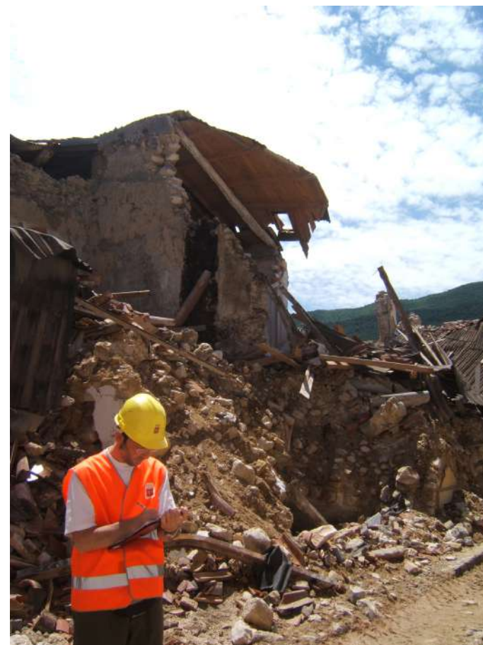
Sisma Abruzzo 2009 Rilievi AeDES in zona “rossa”
